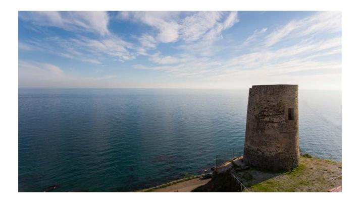
Data del s. XV, fue construida a 40 m de altura en mampostería y mortero de cal. Parte del muro de contención que da a la carretera ha sido asegurado para evitar el derrumbe de piedras sobre la misma.
